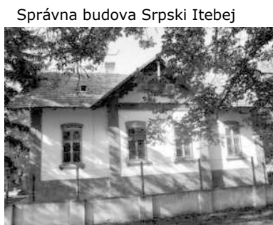
Správna budova Srpski Itebej
